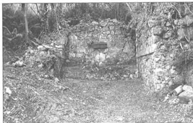
Lámina 5.—Capilla del Angel de la Guarda en Panderrieses (Arenas, Cabrales) tras la limpieza de la maleza y retirada del basurero que la ocupaba.
